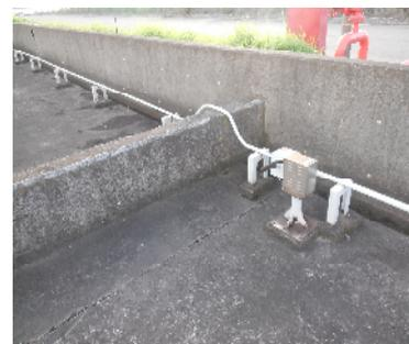
図 6-1-4 仕切堤の例
