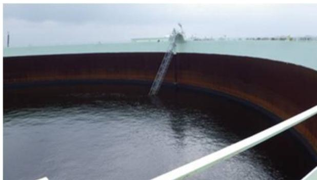
写真10-4-2 浮き屋根が完全に沈んだ状態
