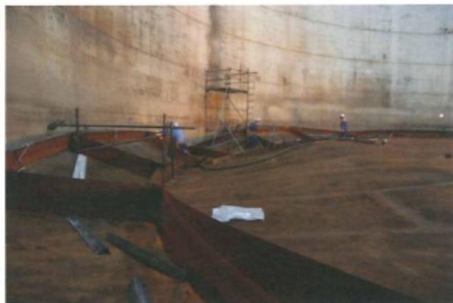
写真10-5-1 浮き蓋の破損状況
