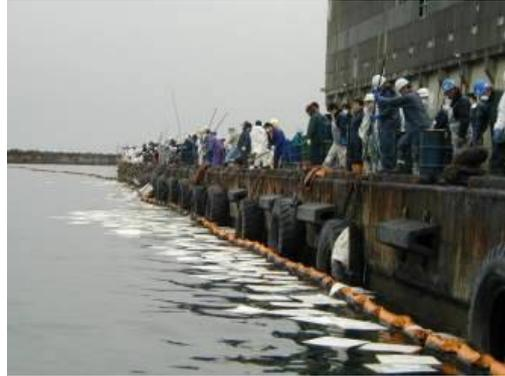
図8-8-7 マット状吸着材の誤った使用例
