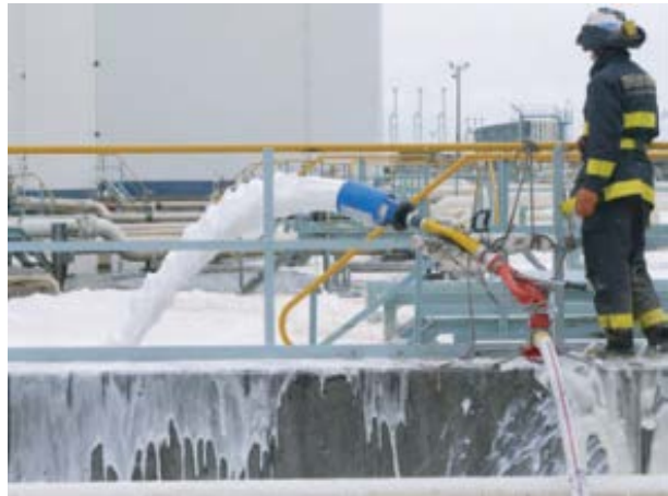
写真 10-3-5 消防隊による泡パージ
