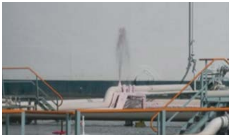
写真10-3-4 ベントから噴出するガソリン(高さ約2m)
