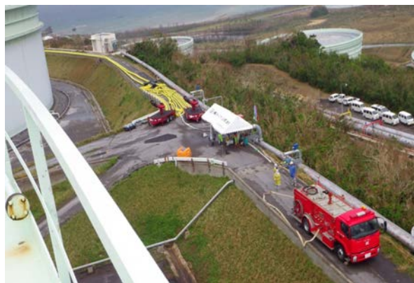
写真 10-4-3 大容量泡放射システムの配置状況
