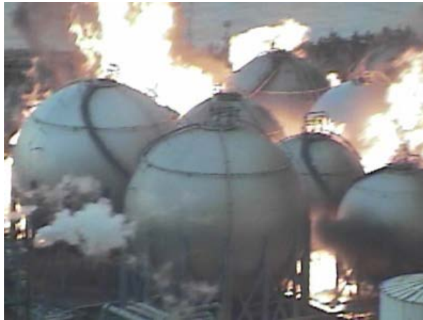
写真 10-2-2 364 番タンク 火災発生 15 時 46 分頃の状況
