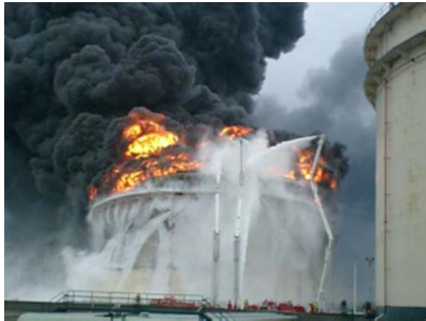
写真 10-1-3 ナフサタンク火災
