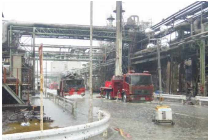
写真 10-2-4 焼損した消防車
