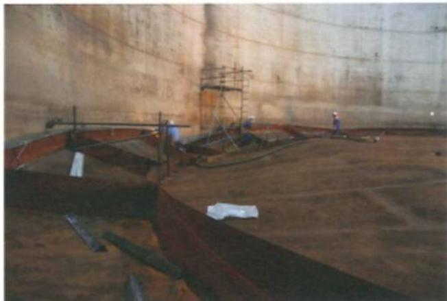
写真10-5-1 浮き蓋の破損状況
