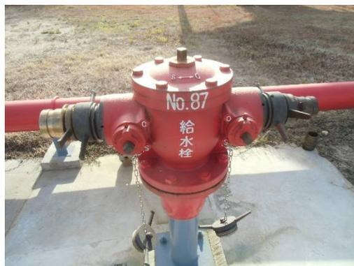
写真7-9-2 媒介金具を結合した状態（左側が75mm、右側が65mm）
