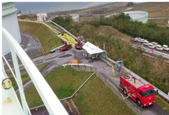
写真10-4-3 大容量泡放射システムの配置状況
