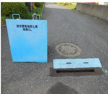
写真6-1-1 地下の排水溝を遮断する水門の例
