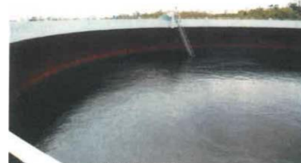
浮き屋根埋没後の状況
