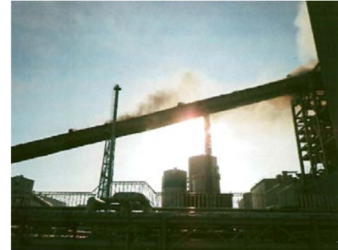
火災時の状況
