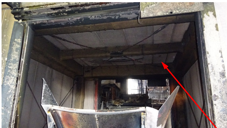
端材室上部開口部(2階部分)の内部
