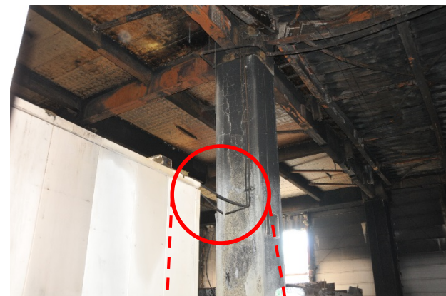
端材室上部開口部(2階部分)付近の配線状況
