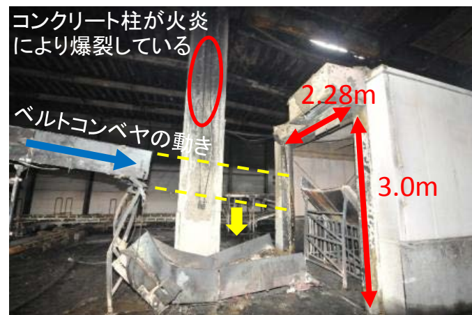
【端材室上部開口部（2階部分）付近】
