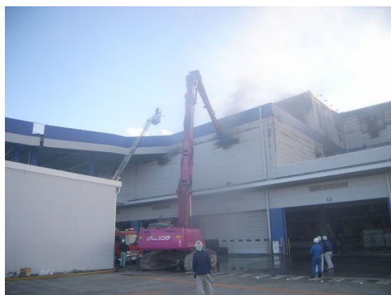
東面破壊状況
