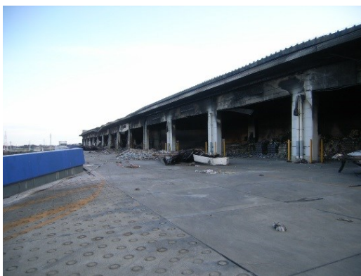
17:00 頃東面 3F ピロティーバース
