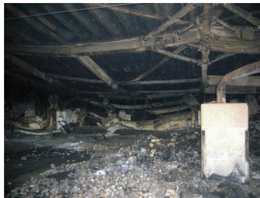
17:00 頃東面 3F ピロティーバース内部
