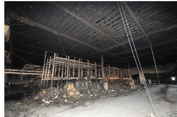
④3階室内の状況
