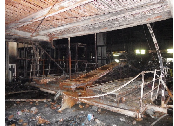
⑧ベルトコンベア落下箇所
