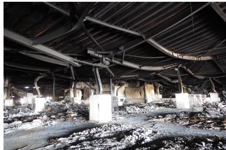
⑪3階階段室付近の状況
