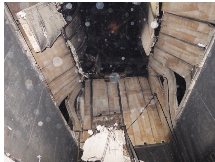
⑫2階～3階の屋内階段の状況
