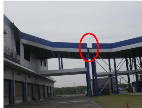
①スロープの外観
