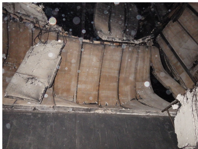
⑬屋内階段内壁(北側)
