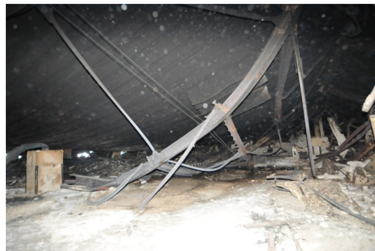
⑨3階室内の状況
