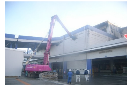
【民間保有の大型重機による外壁破壊】
