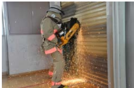
【消防隊保有の破壊器具による破壊】
