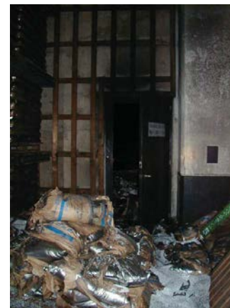
事例1の倉庫内部状況（鎮火後）
