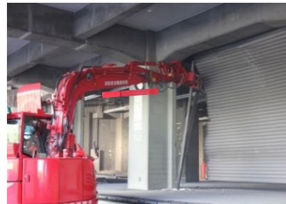
【消防隊保有の重機によるシャッター破壊】
