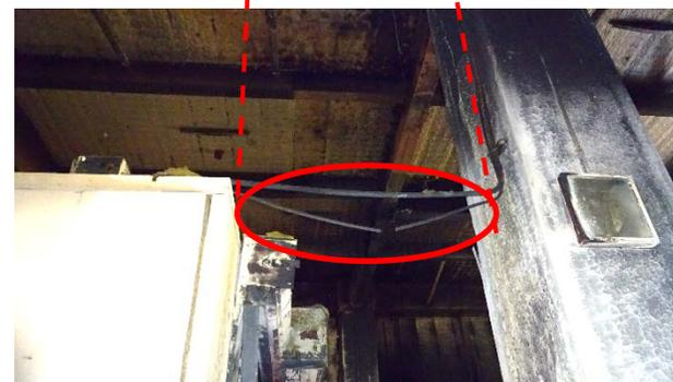
煙感知器の伝送線が収納された保護管(鋼管)の破断状況
