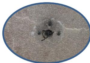
端材室上部の天井面に設置された感知器は脱落し、煙感知器の伝送線が収納された保護管(鋼管)が破断している状況が確認されている。
