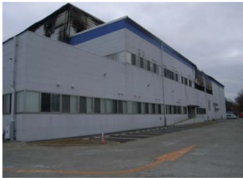
写真 3-1-2 建物状況 (18 日 15 時 17 分頃)
