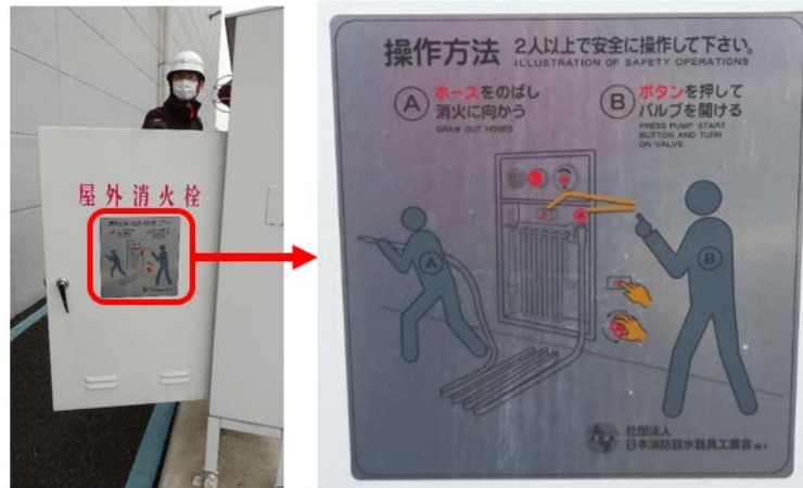
写真 1-3-3 屋外消火設備の操作方法
