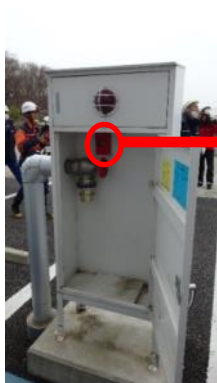
写真 1-2-3 端材室直近屋外消火栓起動ボタンの状況
