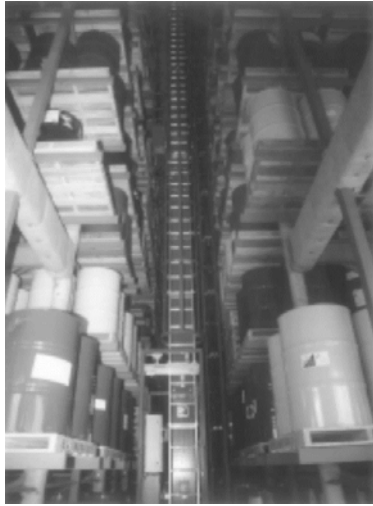
写真 4-1-1 ビル式ラック式倉庫の内観
