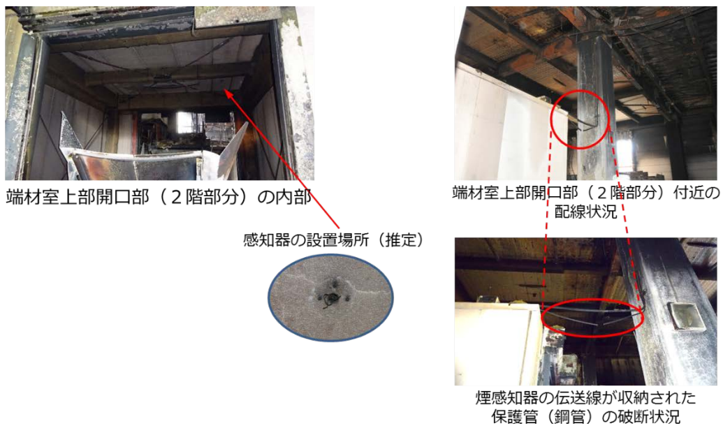
写真 2-3-2 端材室上部開口部
