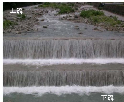
写真 3-14 ローヘッドダム
