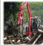
重機による倒木撤去活動
