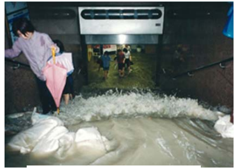
写真 5-12 地下浸水（地下鉄）
