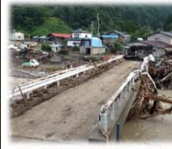
岩泉町安家地区の被害状況
