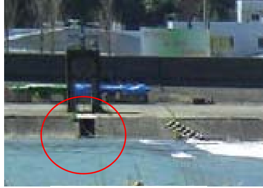
写真 3-15 水路の開口部
