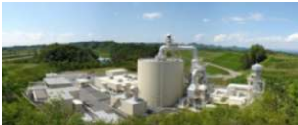
図 1 水素・燃料電池自動車安全性評価試験施設
