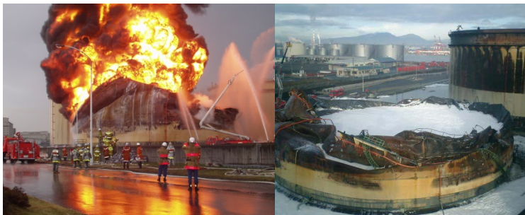
十勝沖地震発生後に発生した苫小牧市の製油所でのナフサタンク全面火災(タンク直径約43m、高さ約24m)
