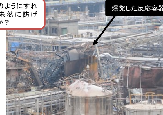
2012年山口県内の化学工場で発生した有機過酸化物が関係する爆発火災事故
