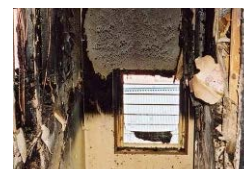
火災現場における階段室内の窓近傍の煤付着状況
