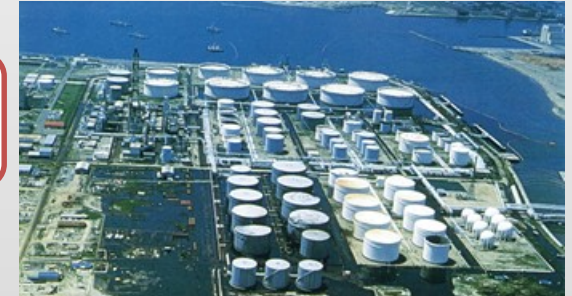
1978年宮城県沖地震 石油タンクにき裂が入り大量の重油が漏洩
