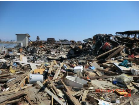
写真A 閑上火災跡の北西面の状況
