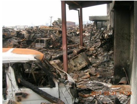
写真B 門脇小学校校舎 1階付近の状況
