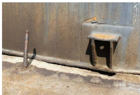
津波で破断したと思われるアンカー
