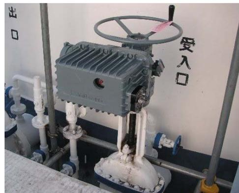
写真 11. 電動アクチュエータの取付
