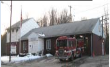
ロCHEDール消防署 (Rochdale)
