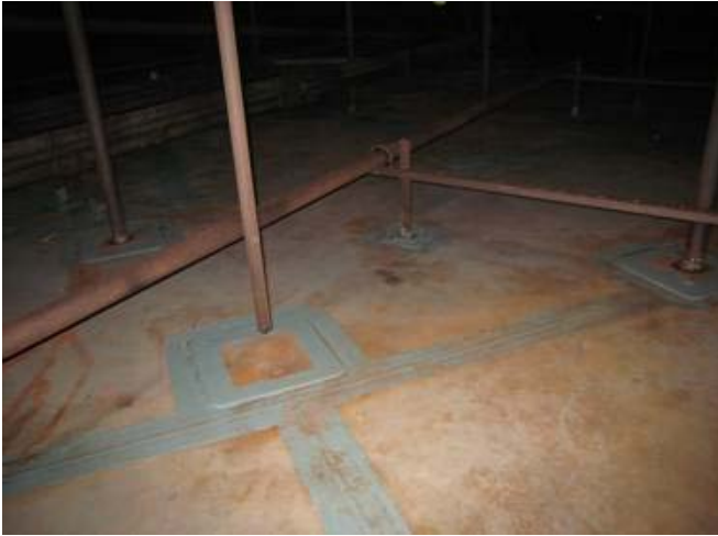
補強塗装部に剥離発生
