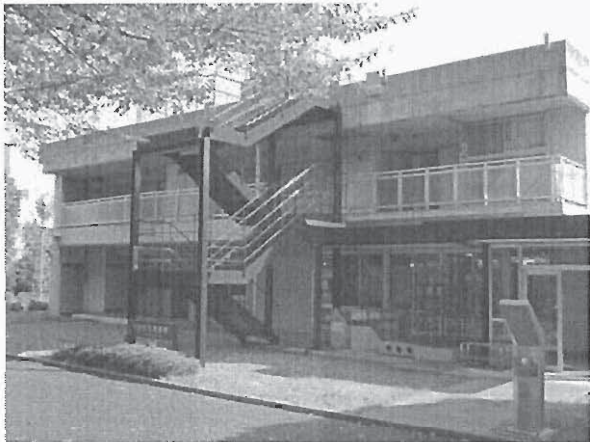
図 2 KSI 住宅実験棟
