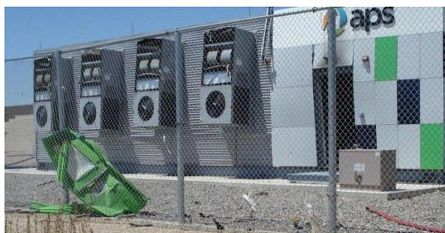
写真 2-2 米国アリゾナ州でのリチウムイオン蓄電池設備の火災
