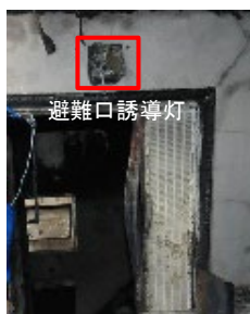
図 15 ③階段室出入口
