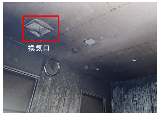
図6 診察室の天井及び壁
