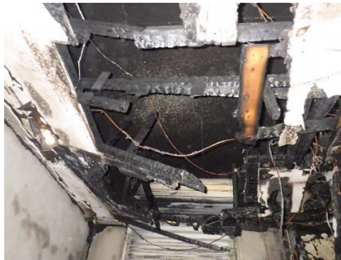
図2 待合室の天井（出火場所付近）
