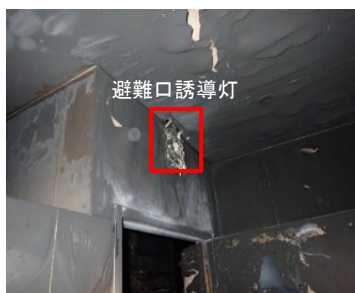
図 14 ②廊下の扉上
