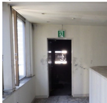
図10 5階空きテナント内部
