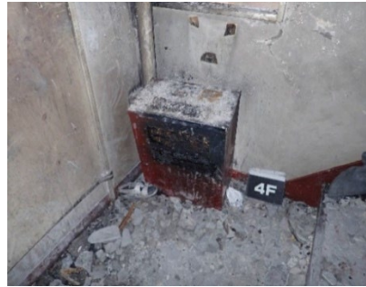
図 22 避難はしご収納箱設置状況
