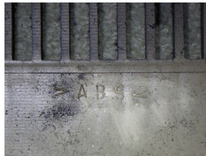
図 38 換気口の材質表示
