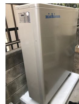
リチウムイオン蓄電池 (16.6kW)
