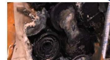
実験後（排出弁の破損状況）
