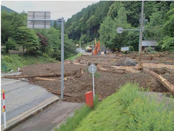
道路の応急復旧（岐阜県建設業協会）
