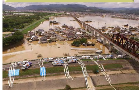
【H30.7月豪雨】 (岡山県倉敷市真備町)
