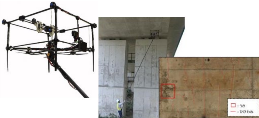
コンクリート橋の点検状況例
