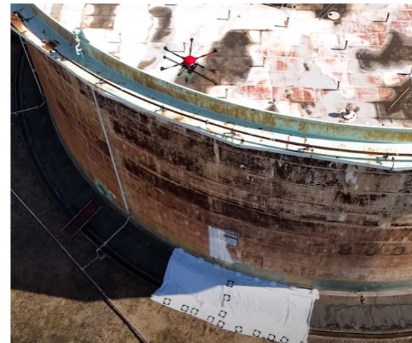
「ドローン壁面補修」(※)の概要、日本製鉄株式会社、日鉄テックスエンジニアリング株式会社との共同研究プレスリリース時の画像より。
