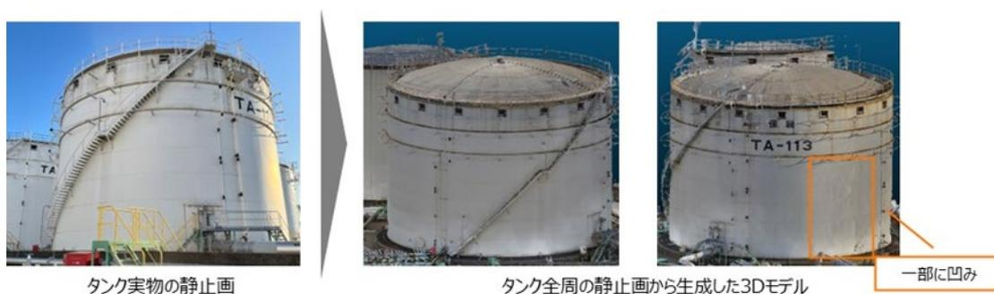
図3-37 実験タンクの3Dモデル
