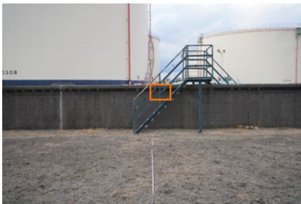
図 3-6 実腐食の静止画比較（防油堤階段）
