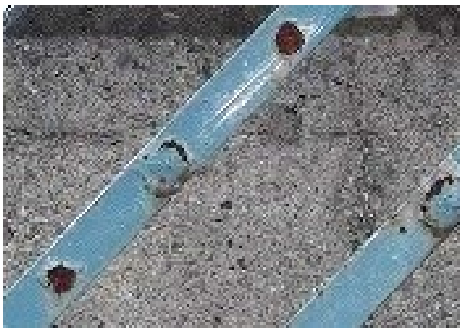
図 3-9 約 1.0mm/px 相当の静止画（撮影距離 9.0m、6,100 万画素相当）
