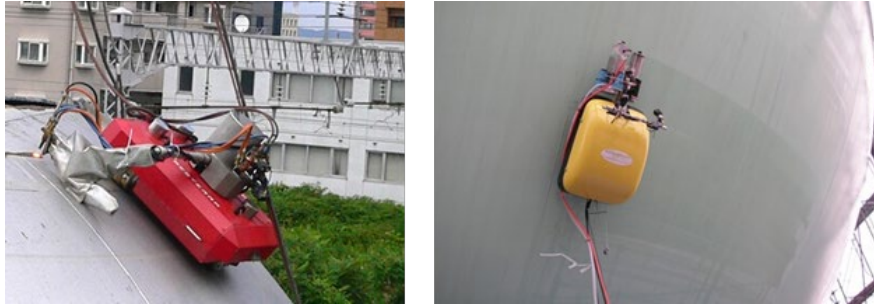
図3 磁石車輪型ロボットの点検イメージ
