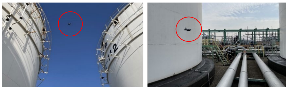
図 3-25 タンク間距離が狭いタンクの外周を飛行させている様子
