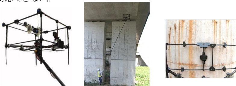
図3 ポールドローンを活用した点検
