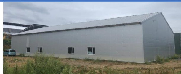
【排水処理施設 外観】
