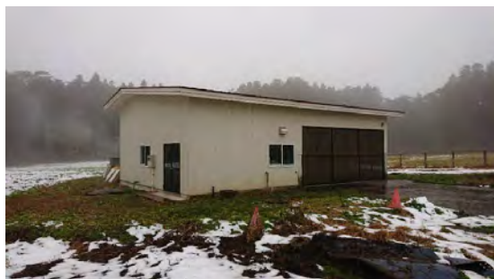
(排水処理施設の外観)
