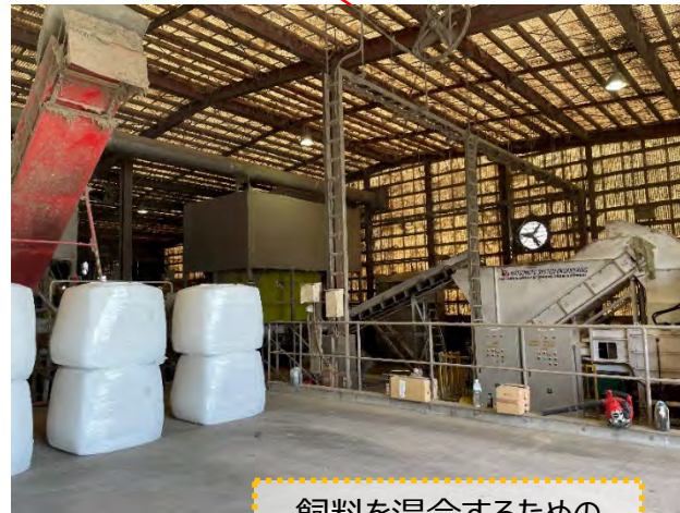
飼料を混合するための 機械等が設置されている
