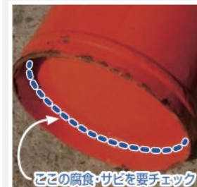
本体容器の点検イメージ (底部の例)
