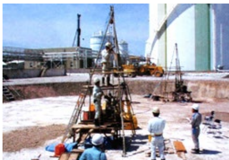
基礎地盤の検査の様子
