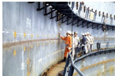
タンク本体の検査の様子
