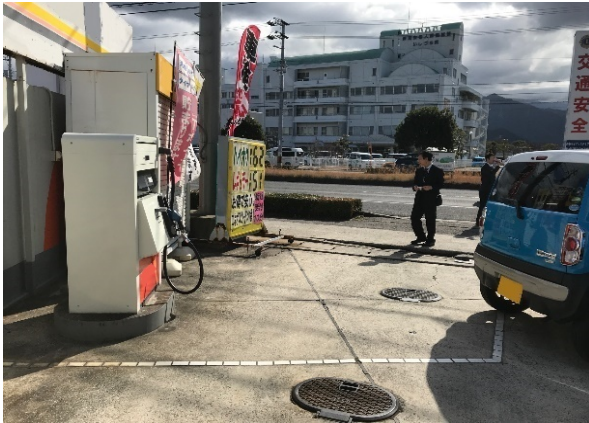
図12 固定注油設備前の作業スペース
