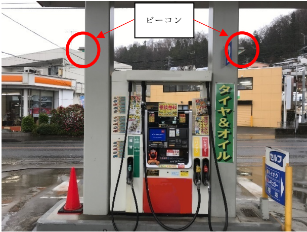
図8 ビーコン設置位置 (小規模施設)
