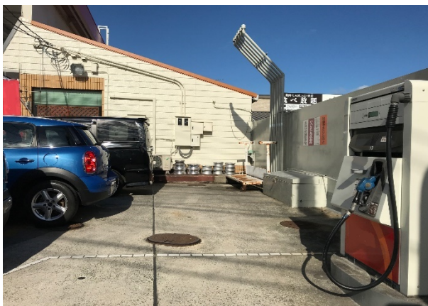
図14 遠方注油口付近の様子
