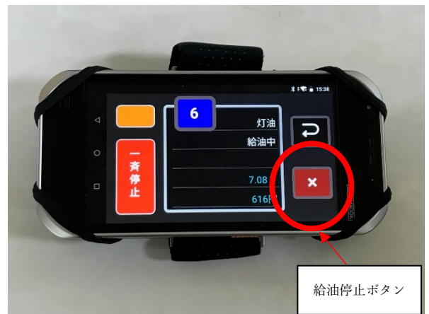
図3 可搬式の制御機器 (給油中)
