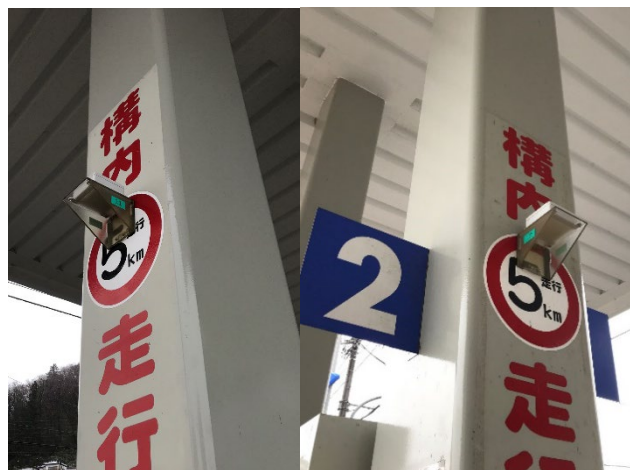
図9 ビーコン拡大図 (小規模施設)
