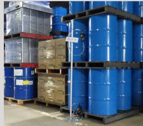
ガス検知器の設置状況（容器付近及び排出設備付近）
