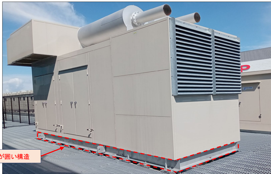
B. 基準の特例により設備の架台に有効な囲いを認めた事例（キュービクル式の架台部分が囲いの構造となっている）
