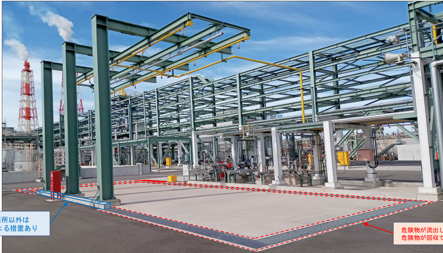
A. 基準の特例により設備の周囲の地盤面に有効な溝を認めた事例（車両の乗り入れ部を溝にしたもの）
