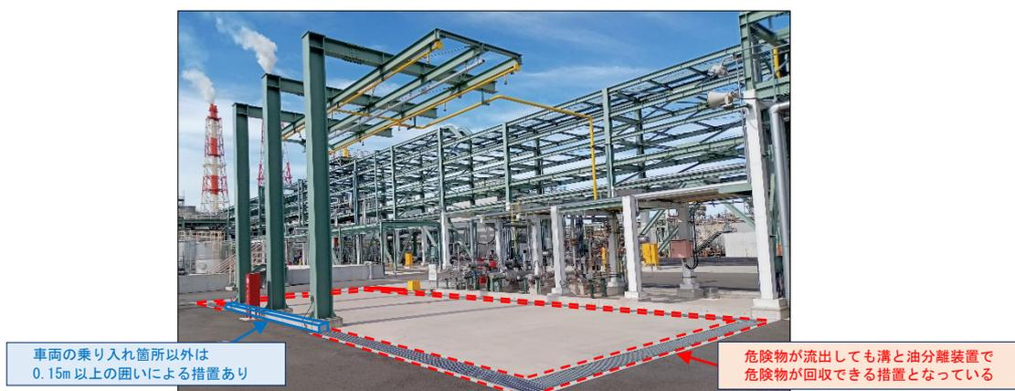
写真 4-1 設備の周囲の地盤面に有効な溝を認めた事例（車両の乗り入れ部を溝にしたもの）
