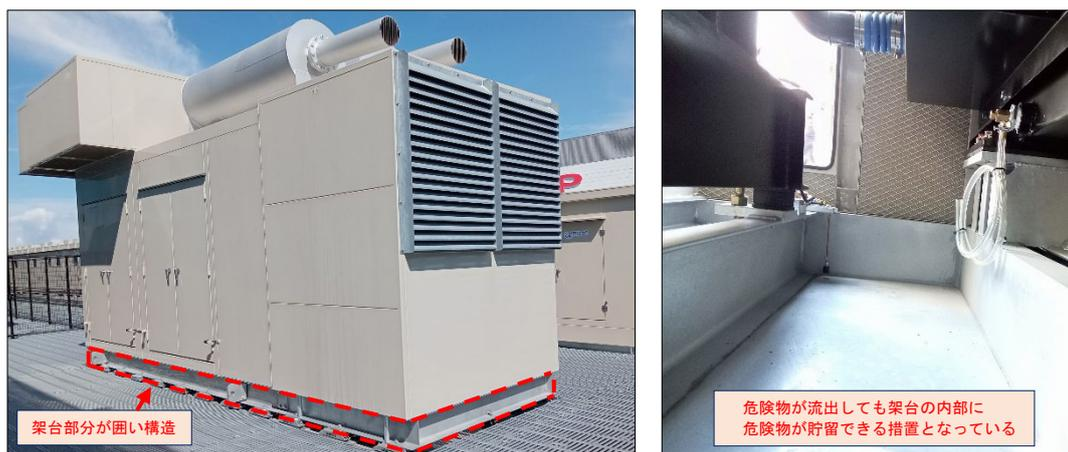
写真 4-2 設備の架台に有効な囲いを認めた事例（キュービクル式の架台部分が囲いの構造となっている）
