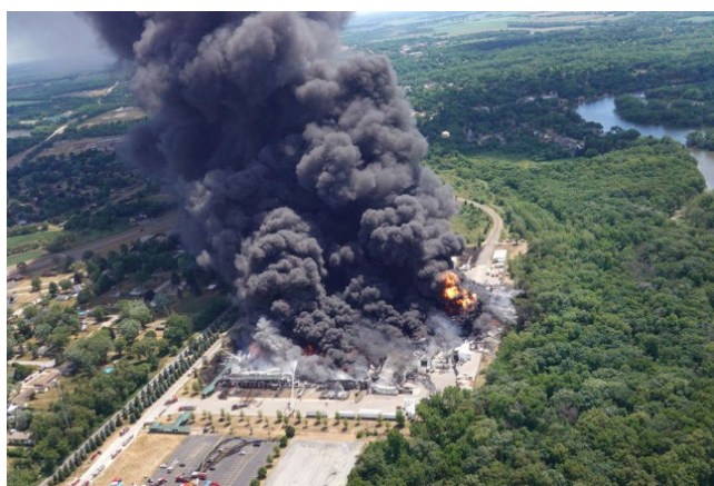
写真 2-1 米国イリノイ州でのリチウムイオン蓄電池を貯蔵する倉庫の火災
