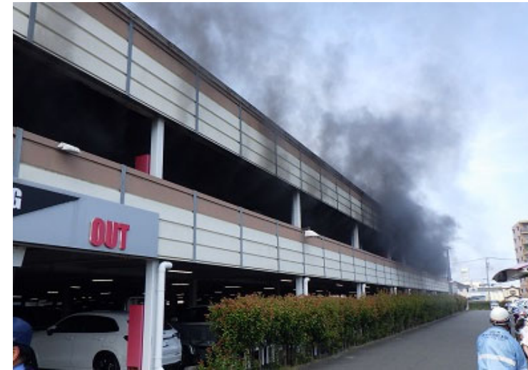
<建物外観（火災時）>
