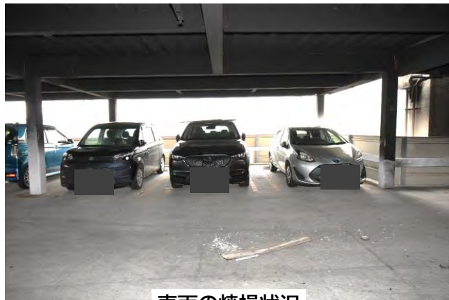
車両の焼損状況
