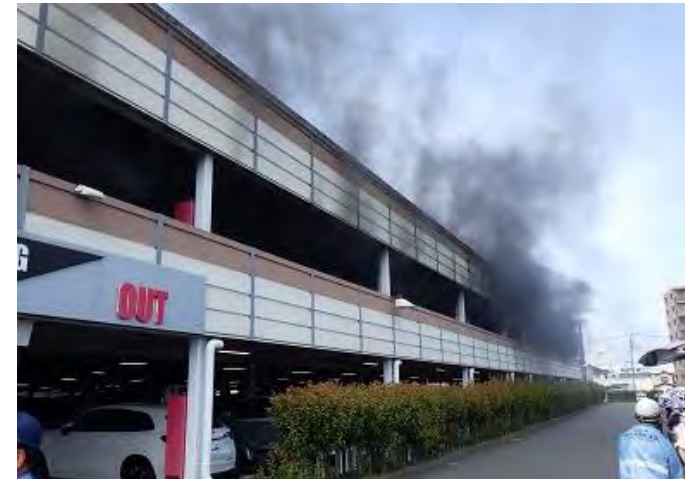
<建物外観（火災時）>
