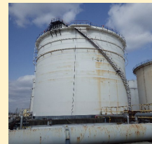
固定屋根式タンク
