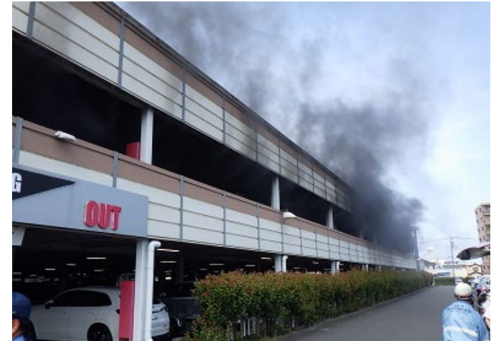
<建物外観（火災時）>
