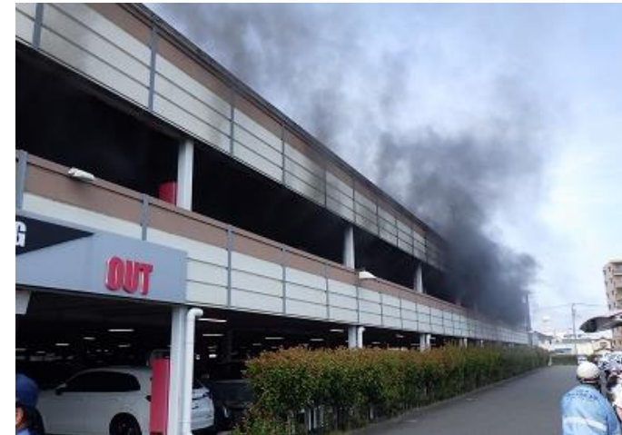
<建物外観（火災時）>
