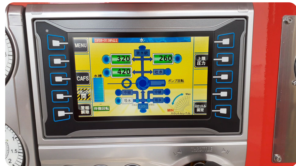
【 同時開栓後の消火栓②の流量状況】
