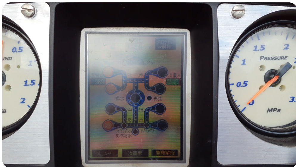
【 同時開栓後の消火栓①の流量状況】
