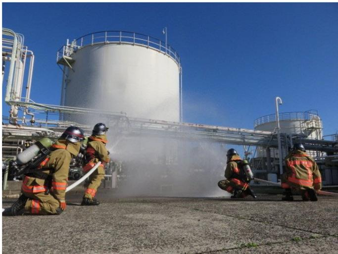
写真 8-3-13 水噴霧注水によるガス拡散防止措置
