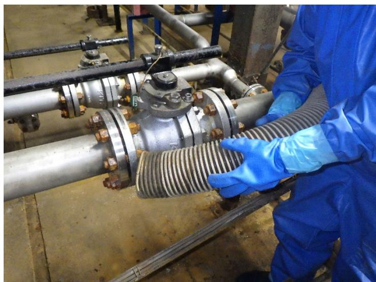
写真 8-3-10 ガス吸引設備によるガス拡散防止措置
