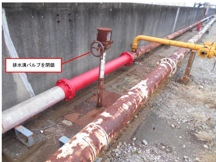
写真 8-3-12 排水溝閉鎖による拡散防止措置
