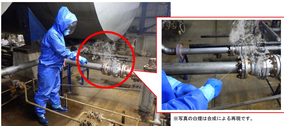
写真 8-3-3 アンモニア水による漏えい箇所の特定
