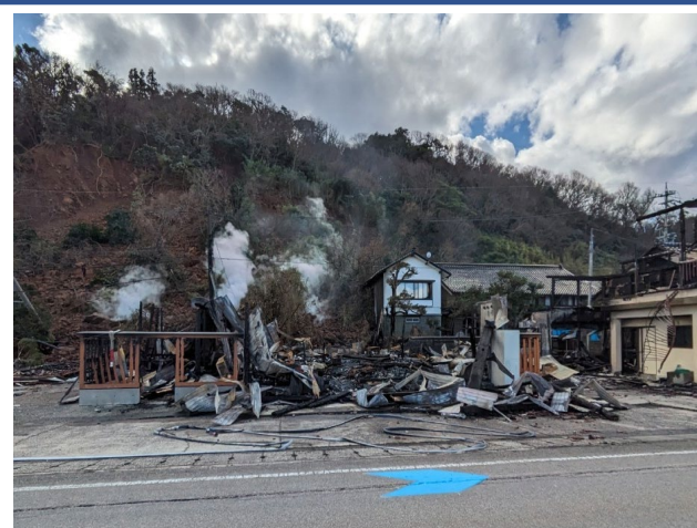
図4 <No. 12> 出火建物の様子 (火災後)
