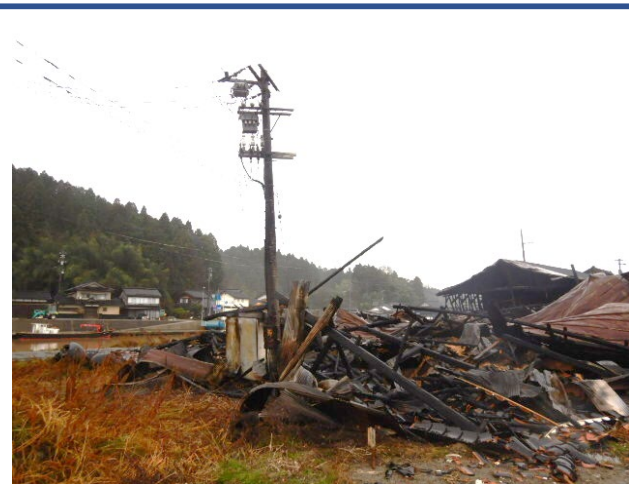
図3 <No. 10> 出火建物の様子 (火災後)
