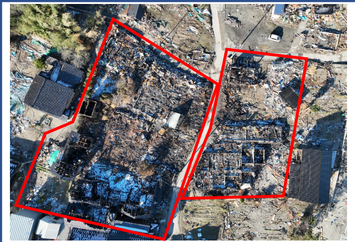
図6 <No. 17> 火災による延焼範囲
