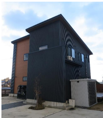
(ア) 南東側から見た建物全景
