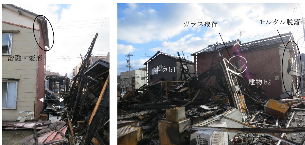
(ア) 北側から西面を見た様子
