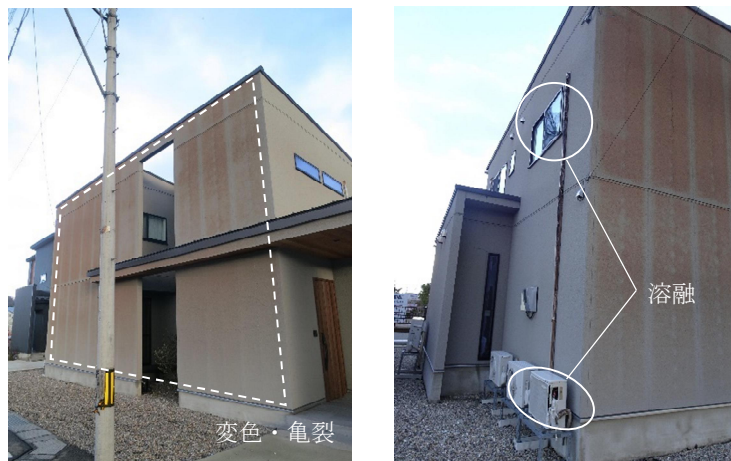
(ア) 南東側から見た建物全景 (イ) 南西角
