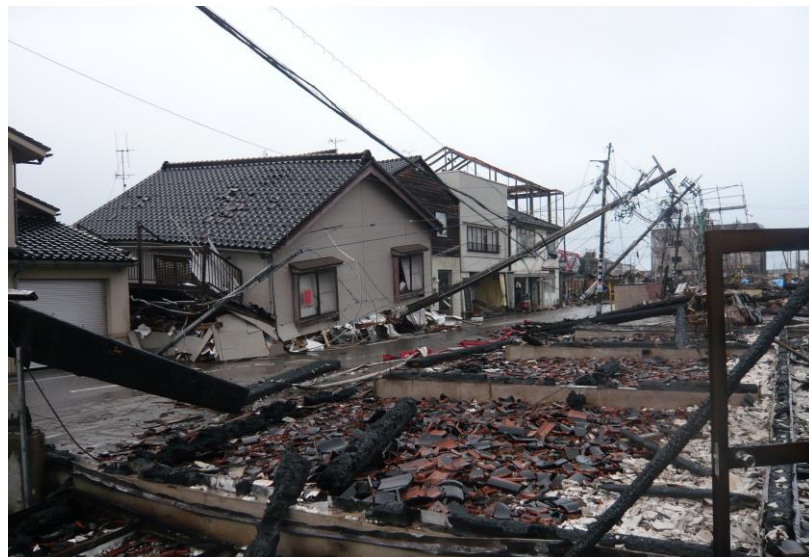
複数の電柱の倒壊による道路閉塞
