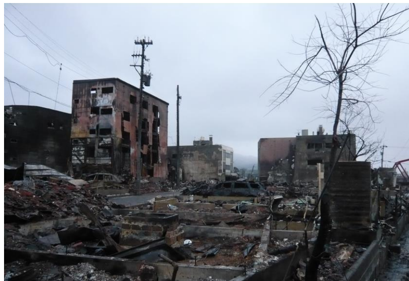
開口部材が脱落した不燃構造の建物（右奥RC造、左S造）
