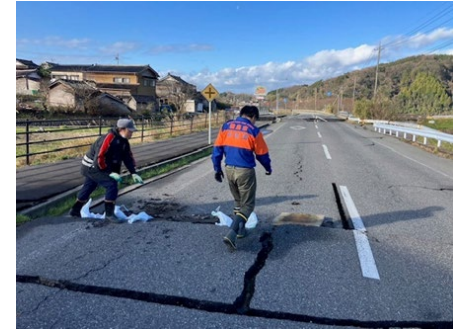
【輪島市消防団による亀裂の入った道路補修の様子】
