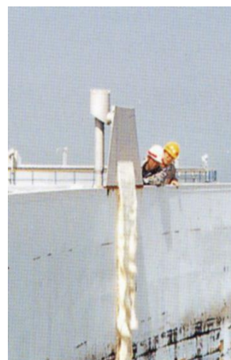
図 2-3 特型泡放出口からの泡放射イメージ 写真 2-2 特型泡放出口からの泡放射状況
